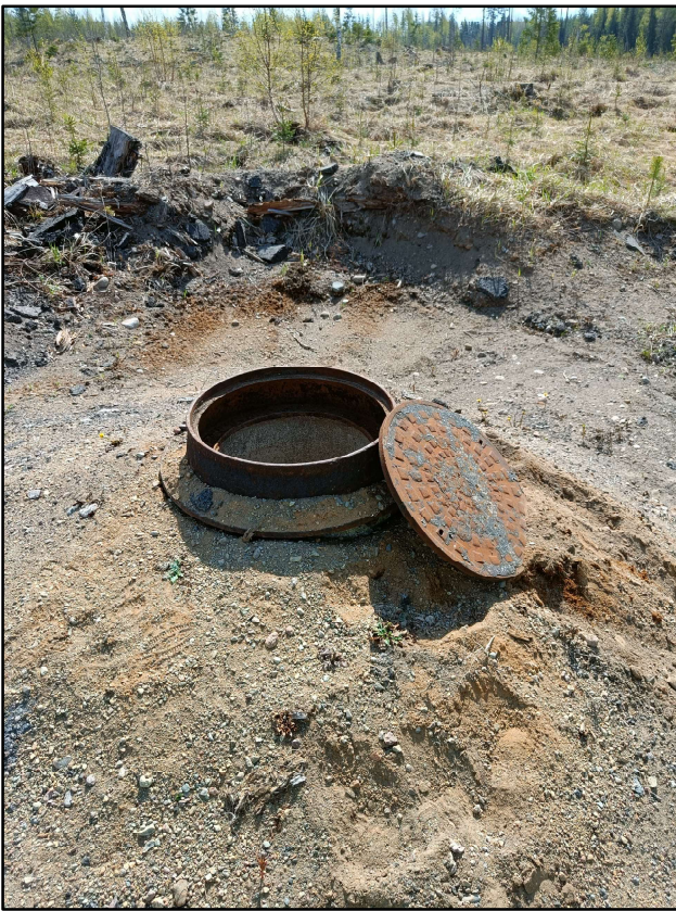
Kuva 3 Kuva hulevesiviemärin kokoojakaivosta.
