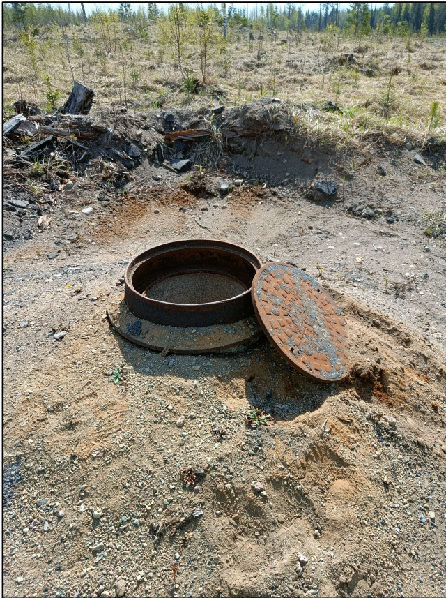
Kuva 3 Kuva hulevesiviemärin kokoojakaivosta.
